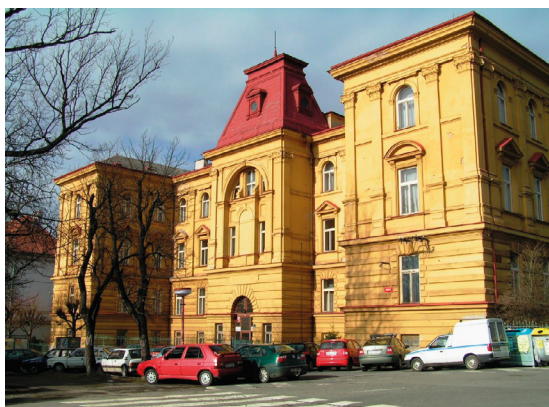
Obr. 2 Rektorát Vysoké školy báňské v Příbrami sídlil v letech 1922–46 v budově bývalého nového konviktu v Jiráskových sadech. Část prostor zde v době existence Versuchanstalt Waffen-Union (zřejmě zde bylo i ředitelství celého ústavu) využíval i Fyzikální výzkum ŠZ. Zdroj: Wikipedia
