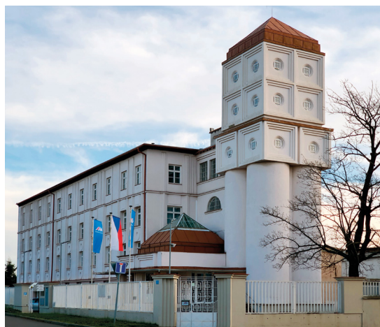
Obr. 2 Budova bývalých automatických mlýnů nedaleko nádraží Praha-Hostivař, v jejíž zadní části sídlil v letech 1950–55 Ústav (resp. Laboratoř) pro nukleární fyziku [8]. Porovnán je stav v 70. letech (a) [8] a dnes (b). Foto: J. Valenta, 2024
